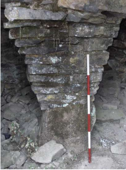
Foto 02. Vista Frontal de una columna central con forma de trapecio invertido.
