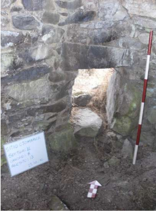
Foto 05. Vista desde interior del acceso que se orienta a un espacio abierto.
