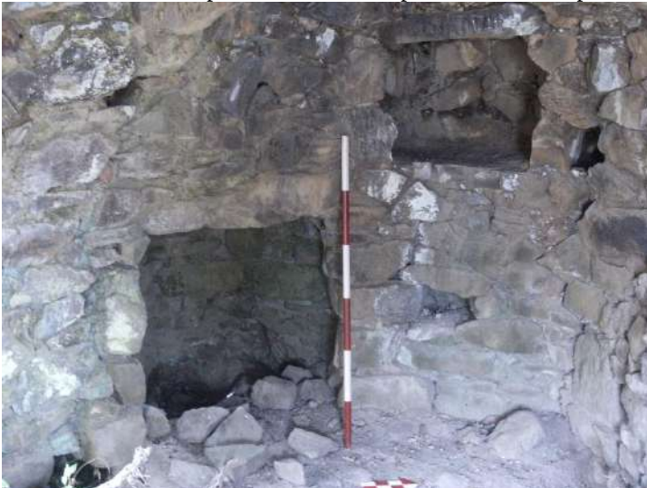
Foto 03. Cámaras dobles independientes con el espacio interior colapsado.
